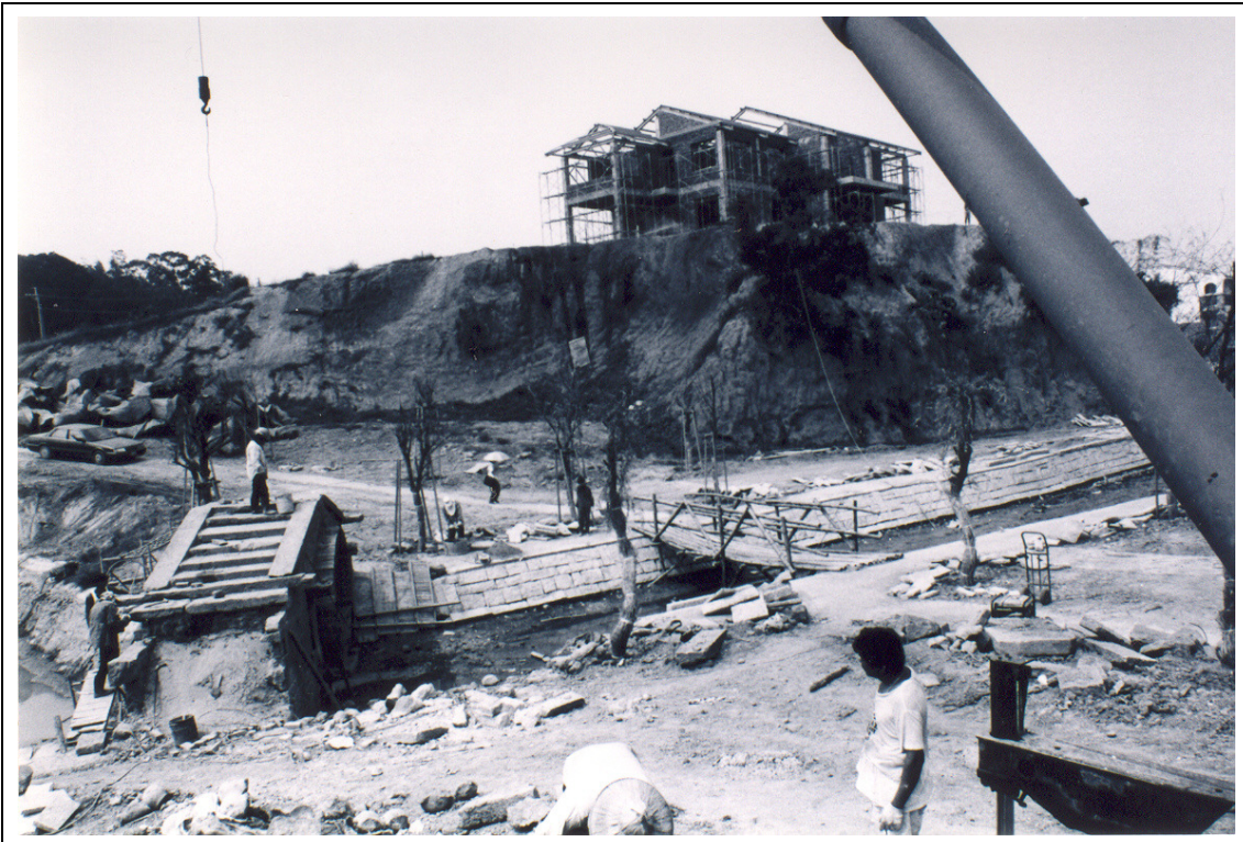
施工中的同安橋及教師聯誼廳
