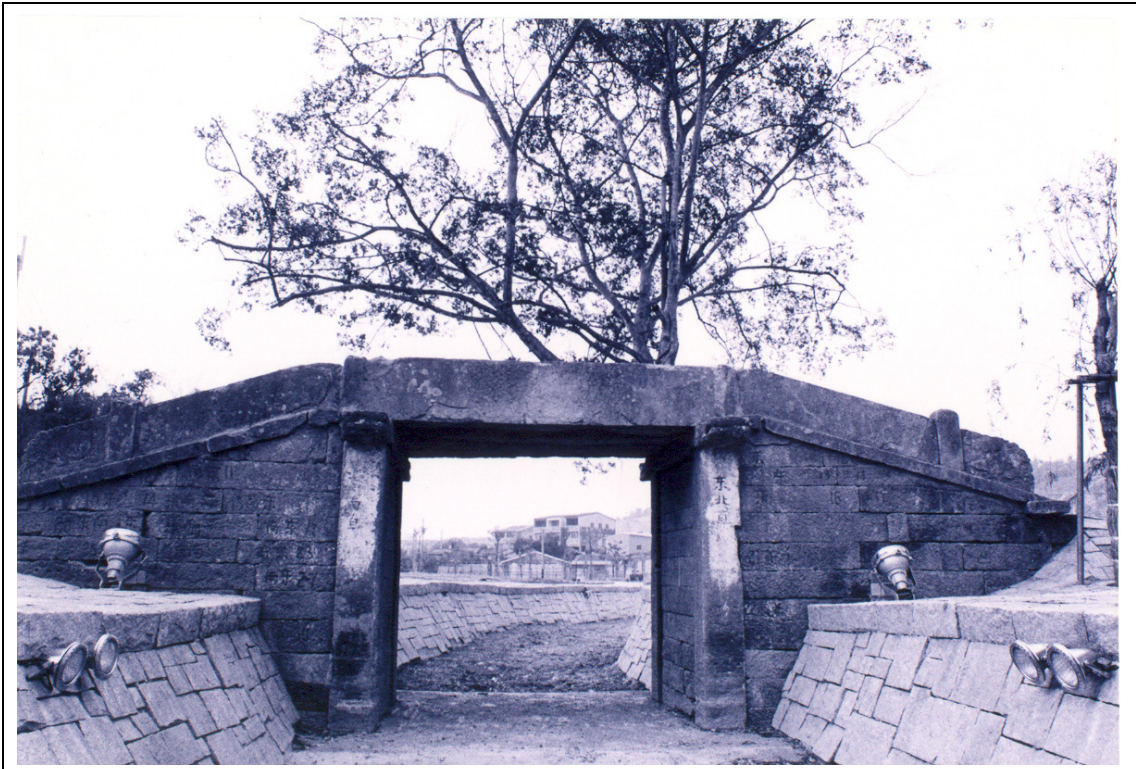
完工的無名橋
