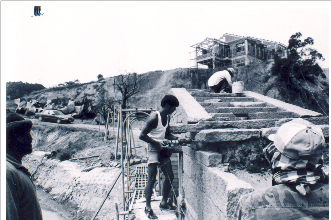
施工中的同安橋及教師聯誼廳
