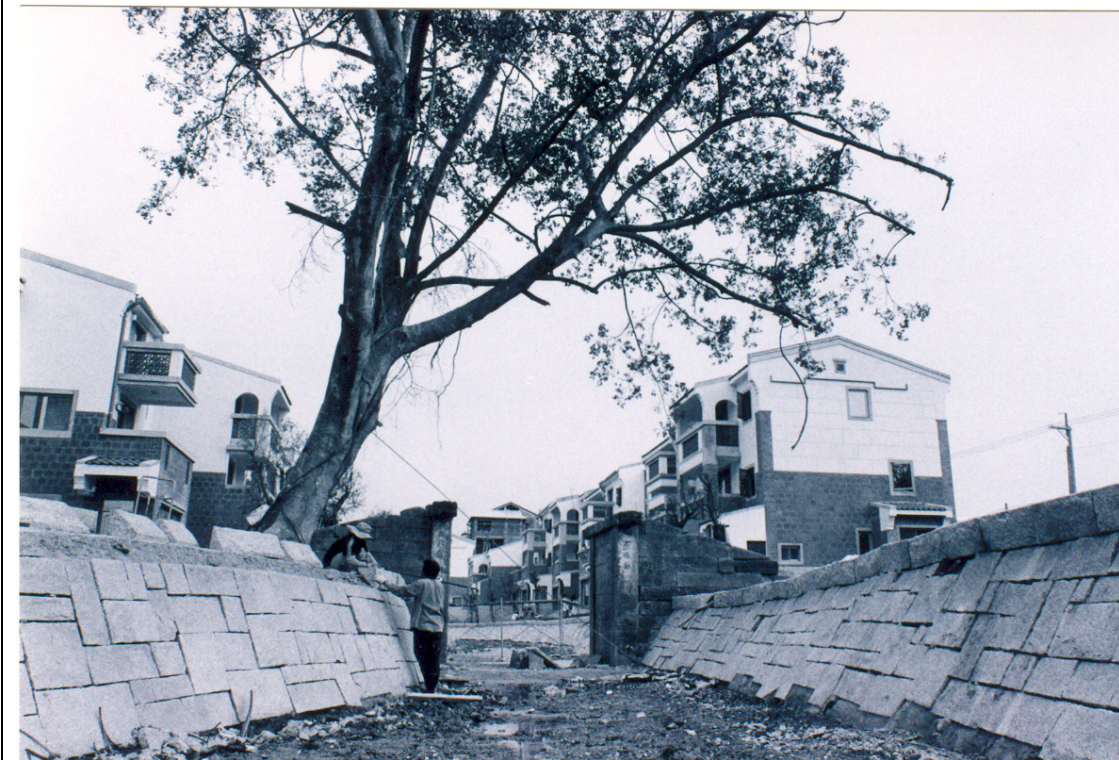
施工中的渠道及無名橋
