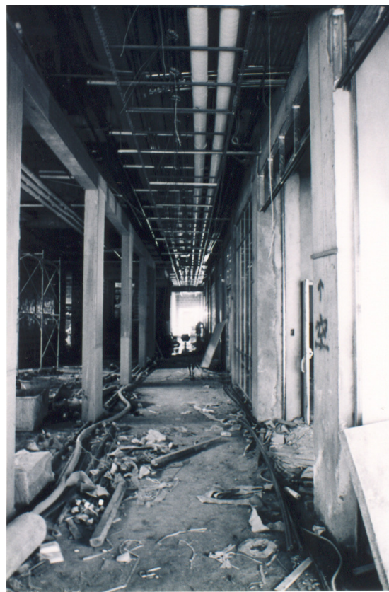
圖資大樓室內管線裝修
