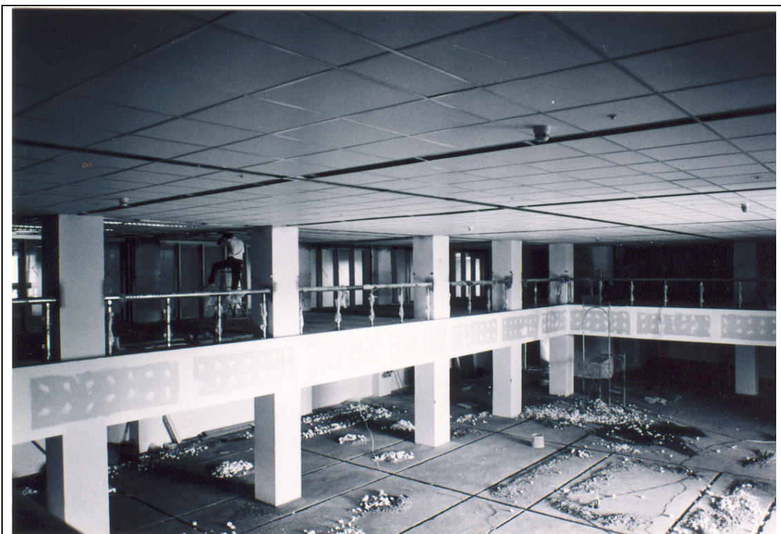
圖書資訊大樓圖書館施工
